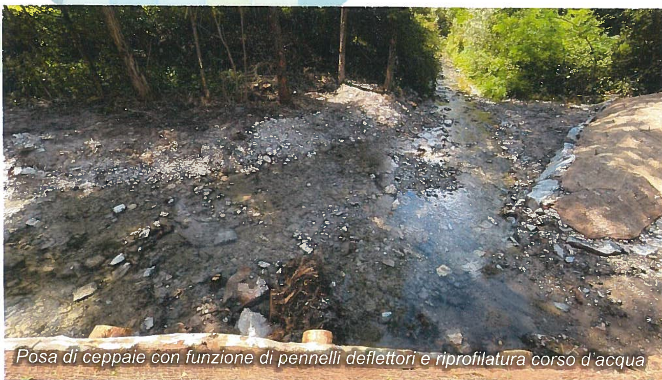
Nuova palificata a ripristino dell'argine e sistemazione confluenza da N
