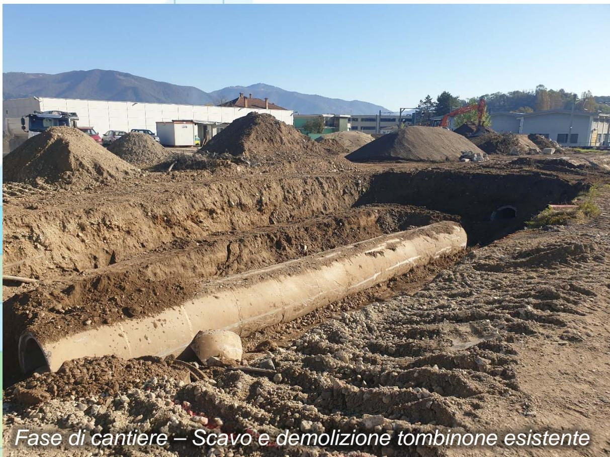
*Fase di cantiere – Scavo e demolizione tombinone esistente*
